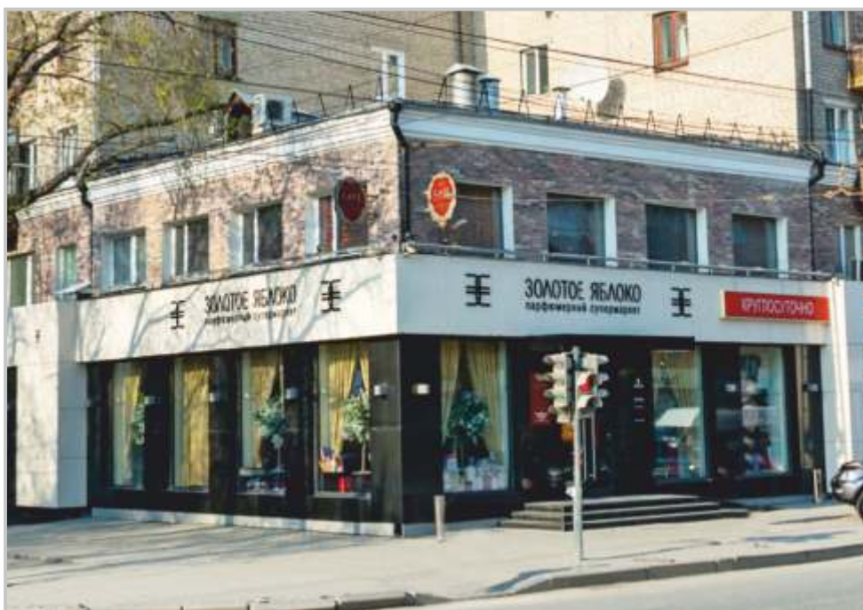
г. Екатеринбург. Магазин "Золотое яблоко". Водосточная система Snegos из оцинкованной стали с порошково-полимерной покраской. 2000г.
