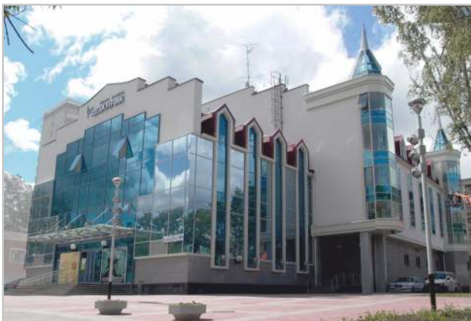
г. Екатеринбург. Муниципальный театр балета "Щелкунчик". Водосточная система и кровельные материалы Snegos. 2010г.
